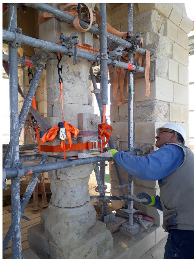
Frettage de la colonne dégagée pour remplacement des assises.
