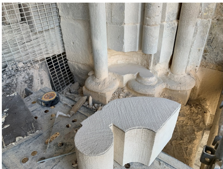
Refouillement de l'assise altérée pour pose de l'élément taillé en atelier, lui-même retaillé au niveau de la queue pour permettre l'incrustement.
