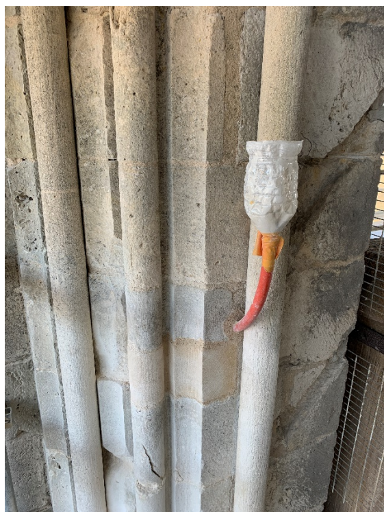
Coulage au godet des joints.
