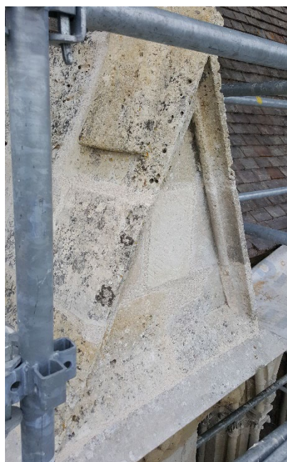
Réalisation d'un bouchon.
