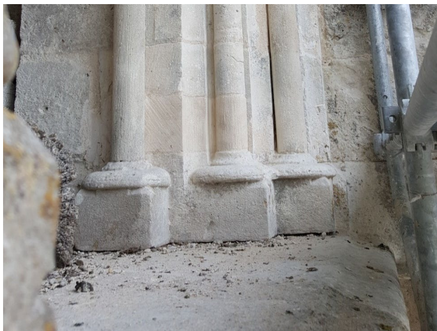
Etat final de la partie basse de la baie.
