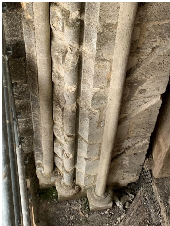
Etat initial de la baie.
