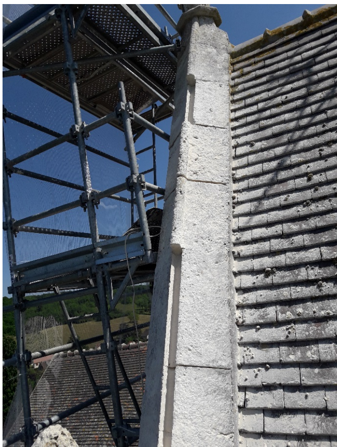
Refouillement des parties altérées.
