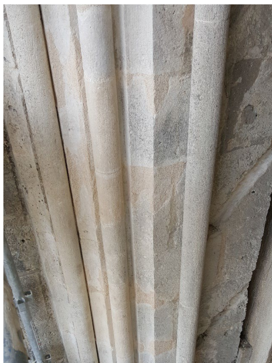
Etat final après jointoiement et ragréages.
