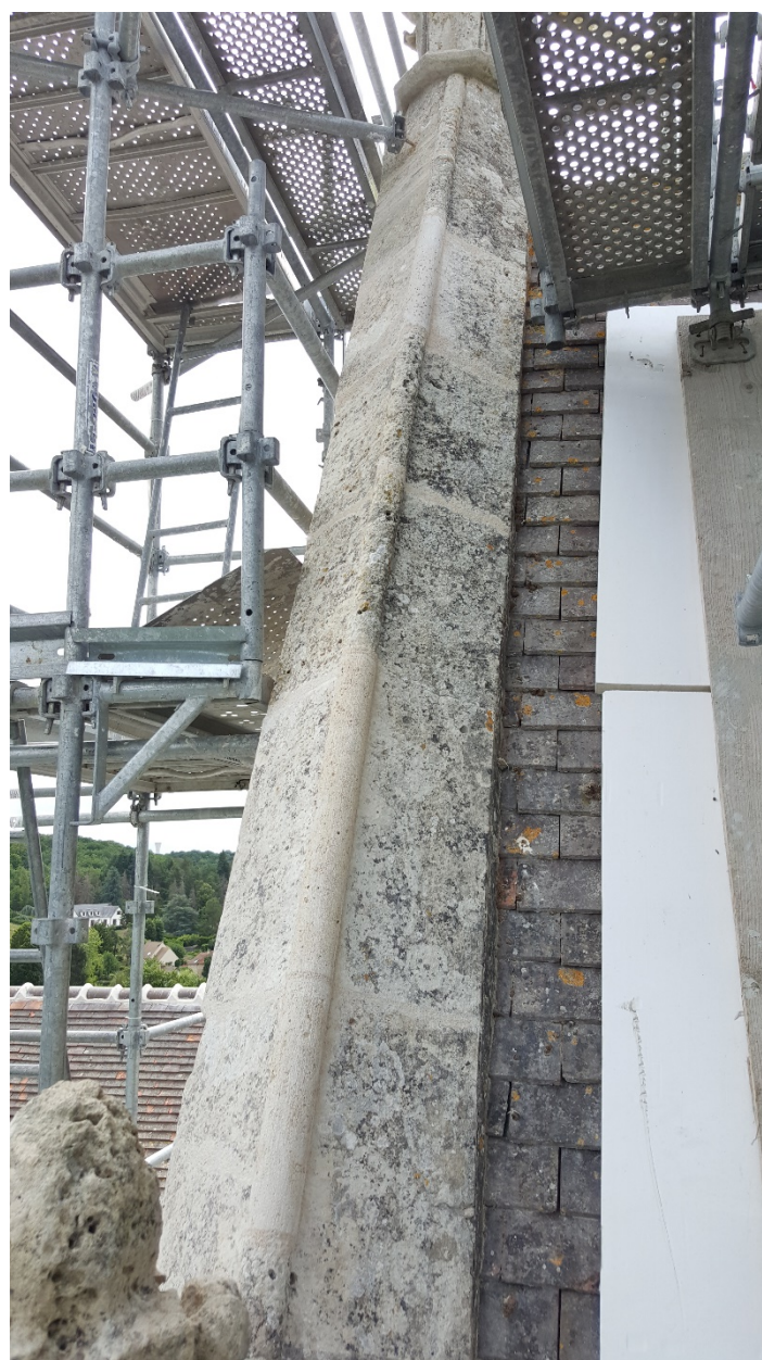
Etat final après pose en incrustement, scellement des goujons et jointoiement.
