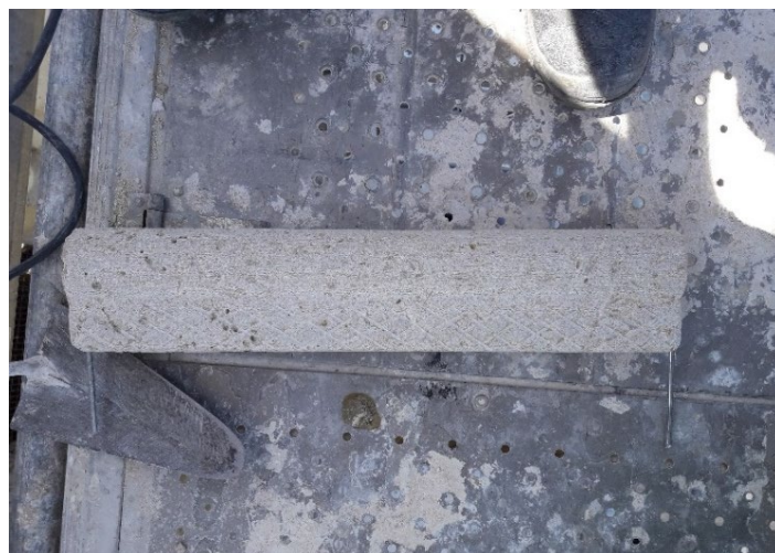
Après relevé du profil, taille en atelier, puis mise en place de goujon pour permettre leur scellement.
