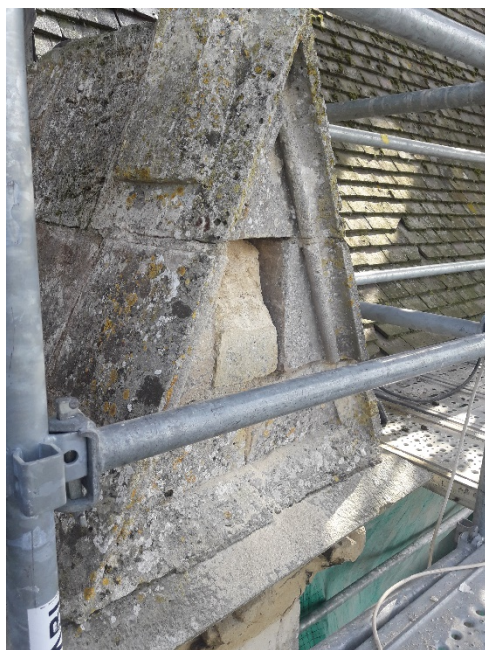
Après nettoyage, purge des parties altérées.
