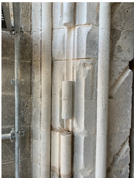
Etape intermédiaire, pour remplacement partiel d'éléments d'assise et de colonnette.
