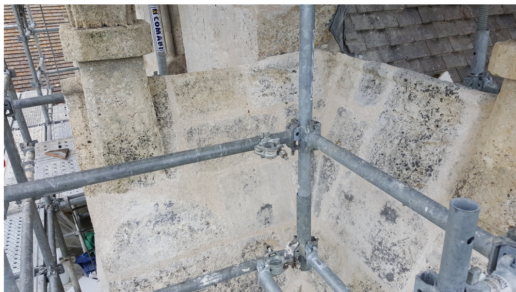
Etat final des culées.
