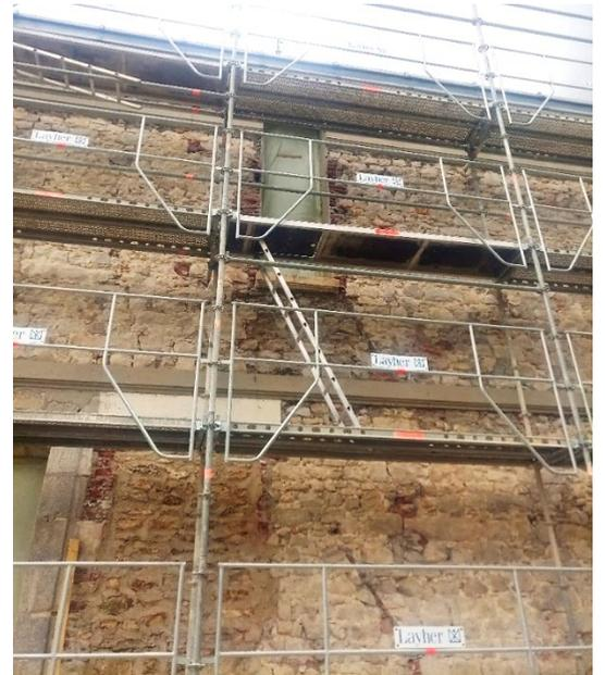
Reprise en sous-œuvre en cour pour bouchement de la porte-fenêtre du RDC, celle de l'étage sera faite ensuite.
